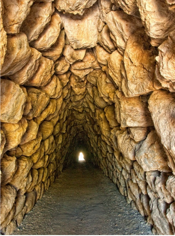
Foto. 24. Yer Kapıdaki Potern-Tünel (Kazı Arşivi)
