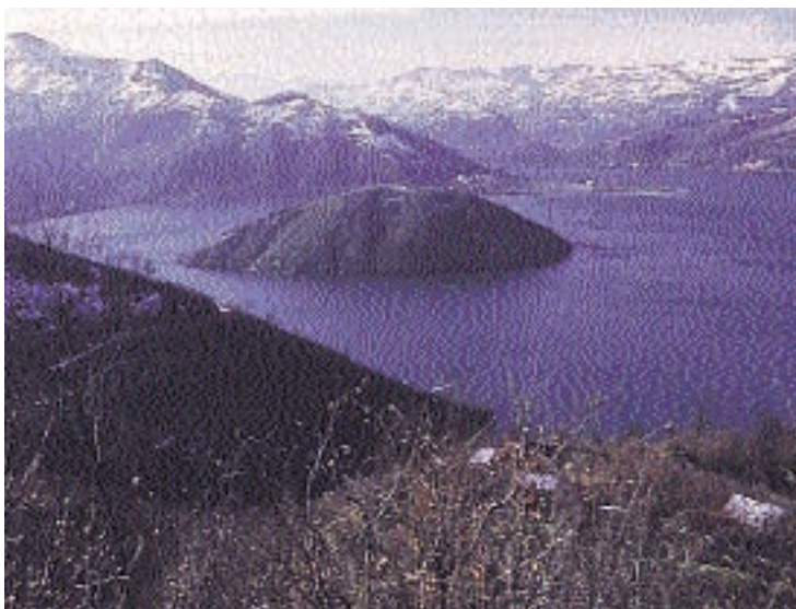
Suat Uğurlu dam and lake
